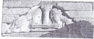
بوابة الأسود بقلعة مايسيني (في بلاد اليونان) القرن ١٥ ق.م. ذات الشكل المثلث والناتج من التقاء السقف الأفقي مع الجوانب المائلة
