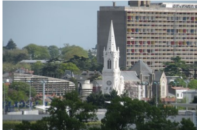
٧٦ - ٢ مبنى مارسليليا السكني
